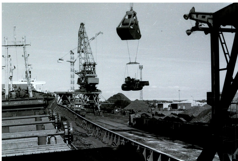
Ein Bulldozer zum Zusammenschieben der Kohlen in den Luken wird aufs Schiff (links) gehievt
